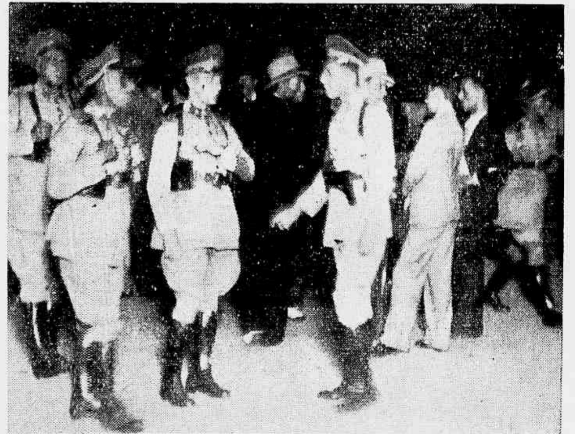
Aspecto tomado esta manhã, na estação Barão de Mauá (Texto noutro local)
